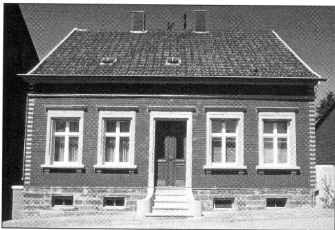
Prämienhaus in der Homburger Straße 77. Beispiel für eine vorbildliche Baurekonstruktion
