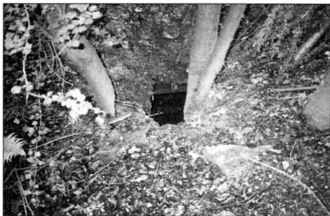
Ventilatorschacht Wasserberg zum Zeitpunkt der Freilegung, August 1997
