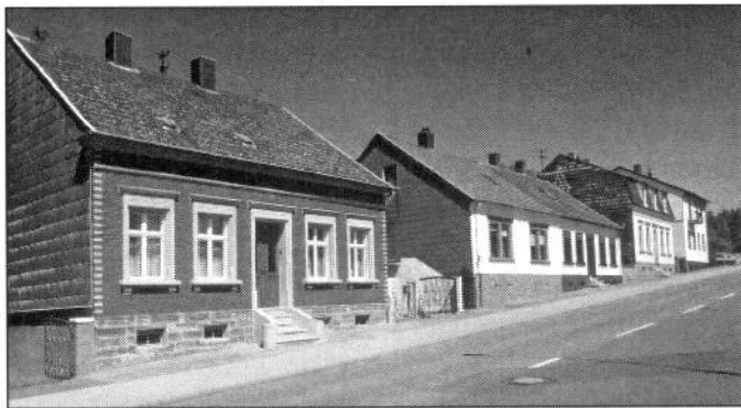
Zeilenbebauung mit Prämienhäusern in der oberen Homburger Straße
